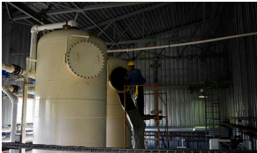
На фото: замена фильтрующих наполнителей в комбинированных фильтрах очистных сооружений.
