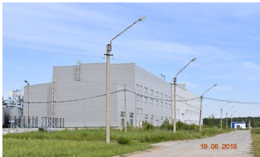
На фото: здание недостроенного завода. Корпус 107.
