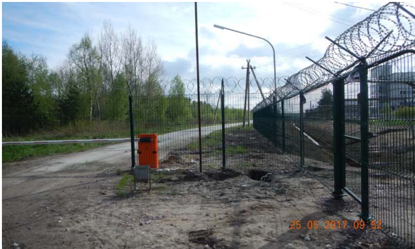
На фото: ограждение территории полигона в 2017 году
