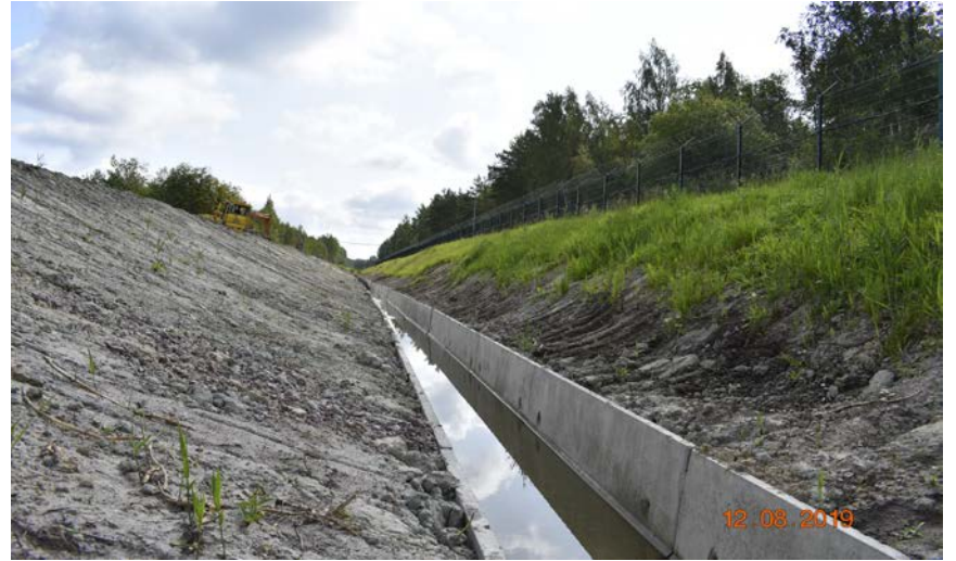
На фото: обводной канал. Август 2019 года.
