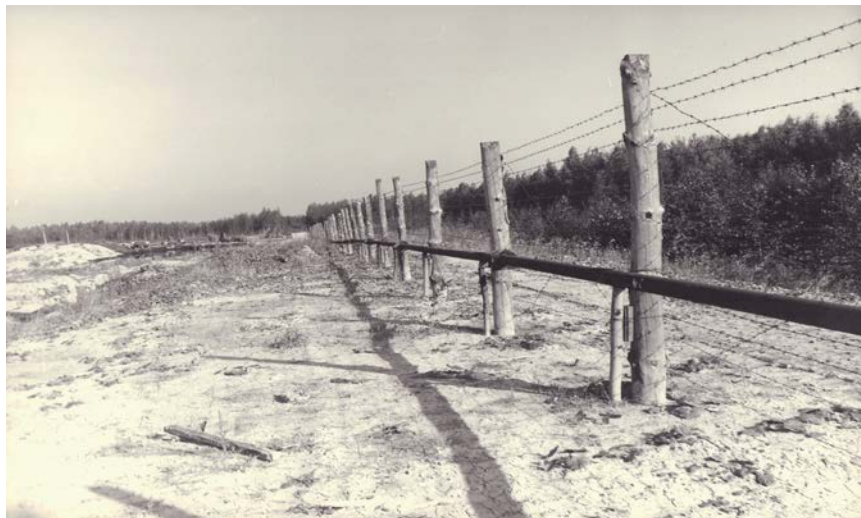
На фото: ограждение территории полигона в 1970 году
