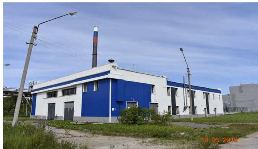
На фото: газомазутная котельная. Корпус 108.
