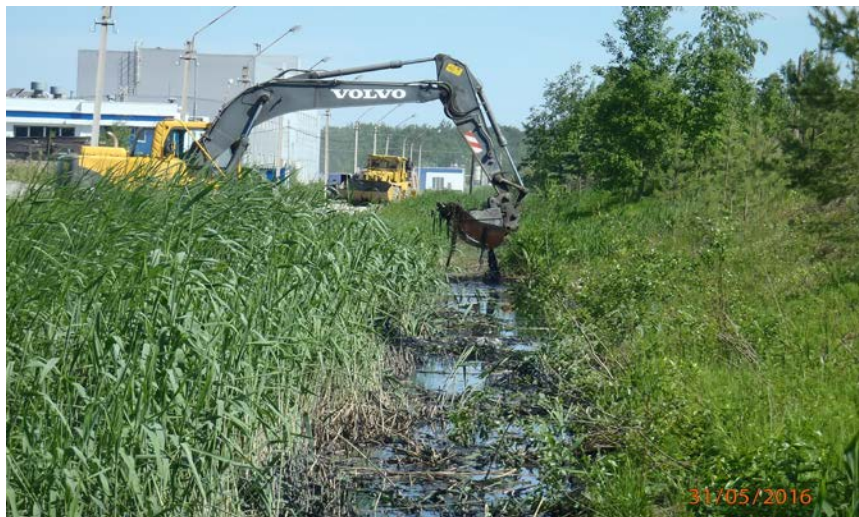
На фото: внутренний канал до очистки. Май 2016 года.
