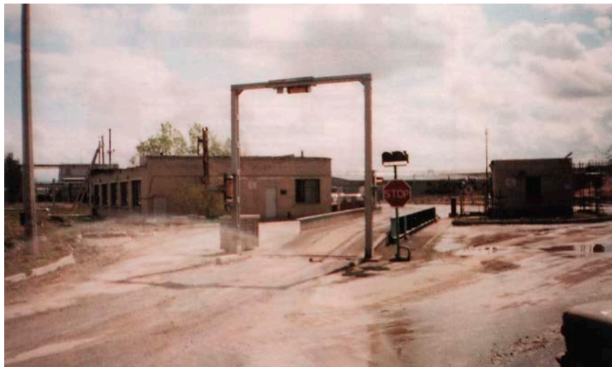
На фото: весовая и система радиационного контроля полигона «Красный Бор».
