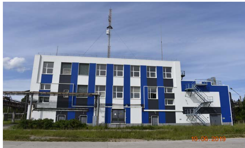
На фото: здание недостроенного завода. Корпус 102-104.
