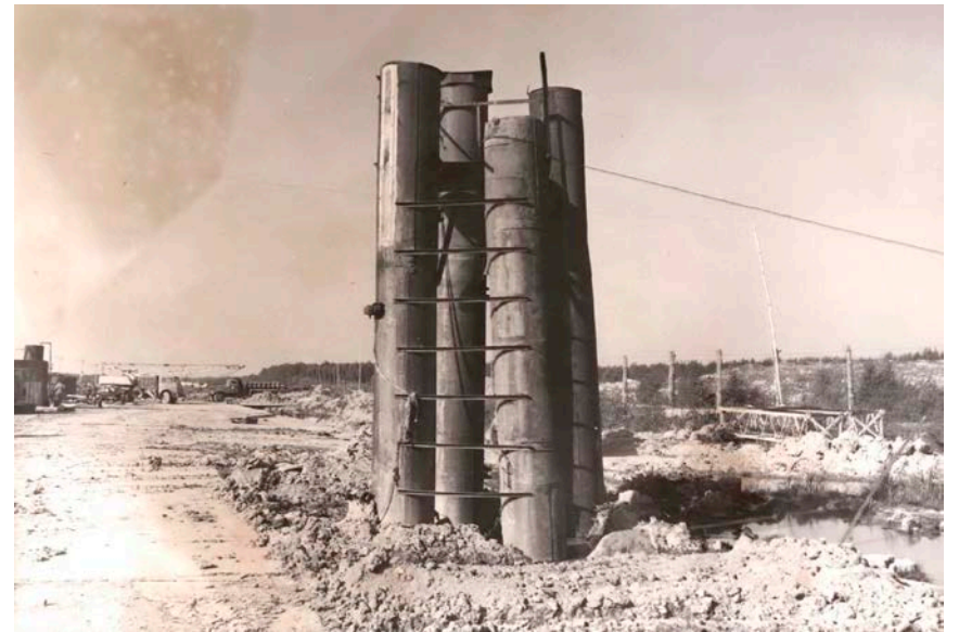
На фото: установка термического обезвреживания (УТО)
