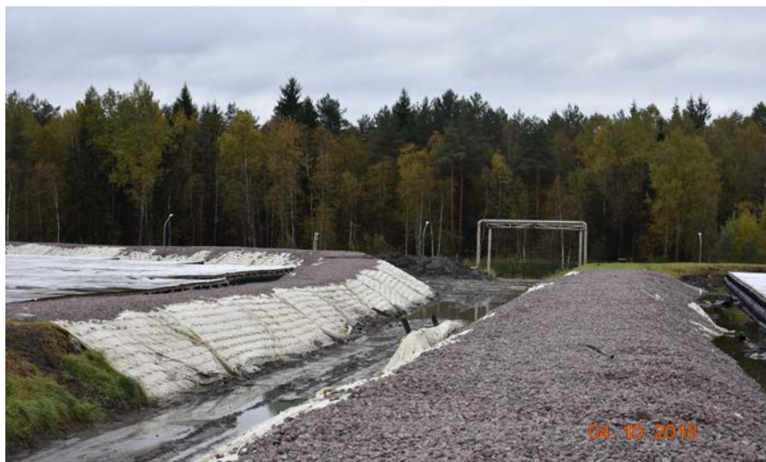
На фото: отремонтированные дамбы обвалования карт №№64,68
