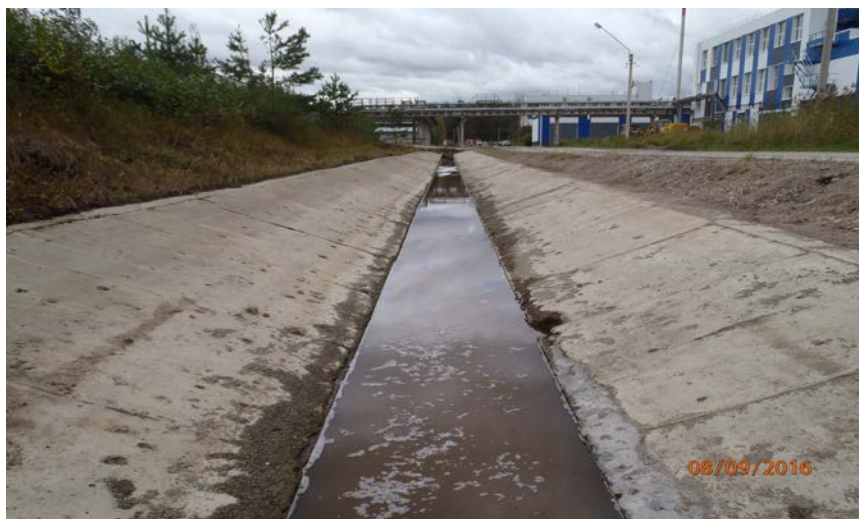
На фото: внутренний канал после очистки. Сентябрь 2016 года.
