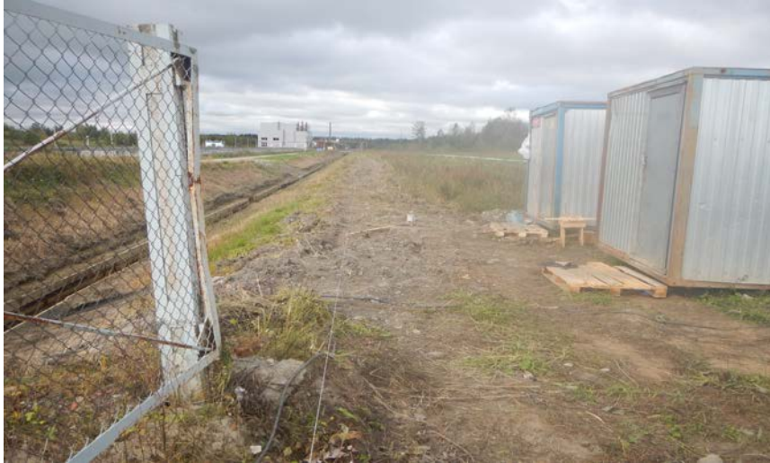
На фото: ограждение территории полигона в 2014 году
